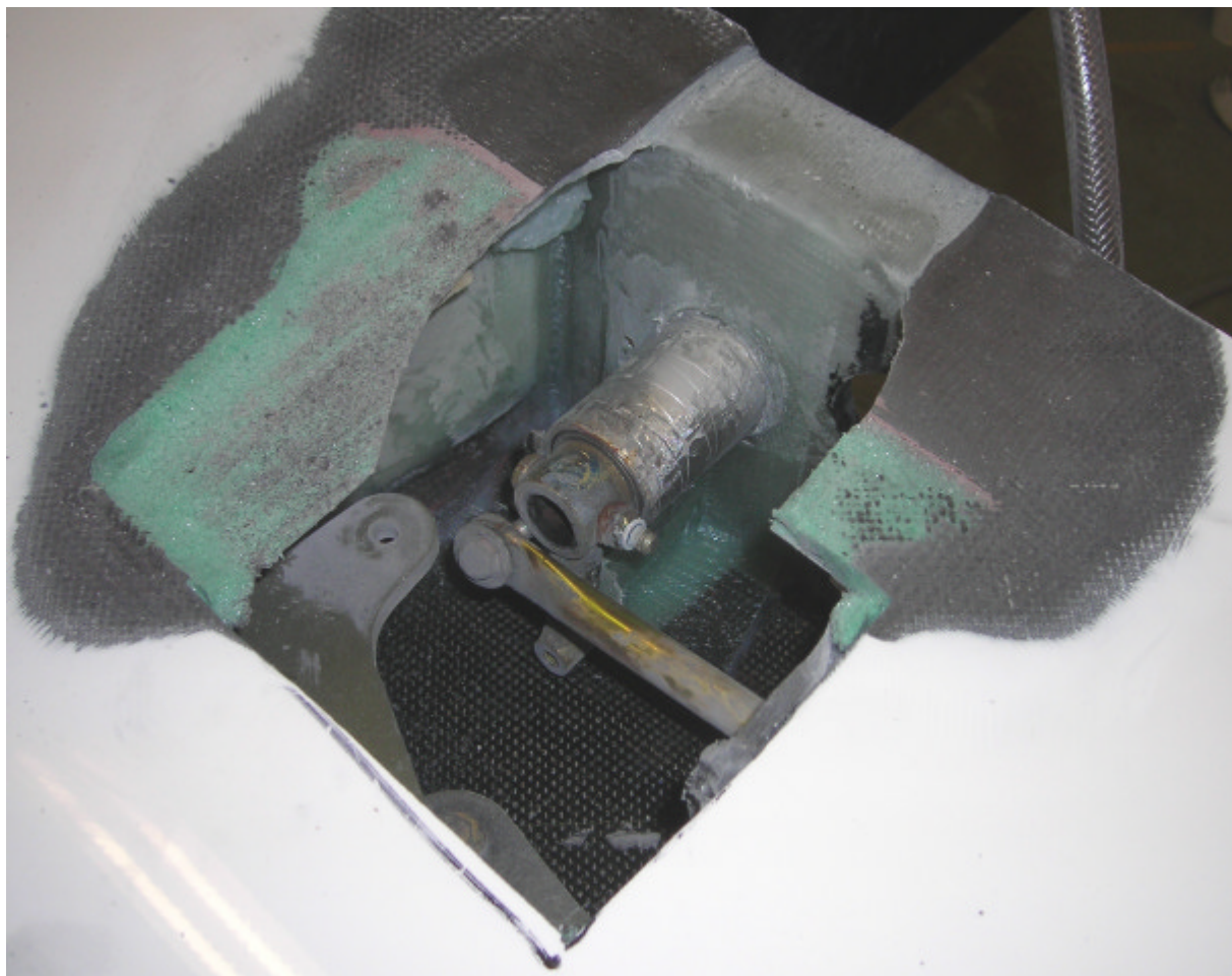
Foto 1: Ansicht der Reparaturstelle, Abstützungen entfernt
